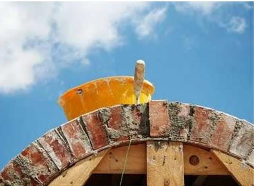
**Dome, è un progetto che vede gli studenti del Laboratorio di Progetto II della Facoltà di Architettura e gli allievi della Scuola Edile di Siracusa impegnati a realizzare in scala 1:1 un sistema abitativo *low-tech*. Archi, volte e cupole in laterizio sono gli elementi costruttivi con cui gli allievi sperimentano le potenzialità d'uso innovativo di materiali e tecnologie della tradizione.**
