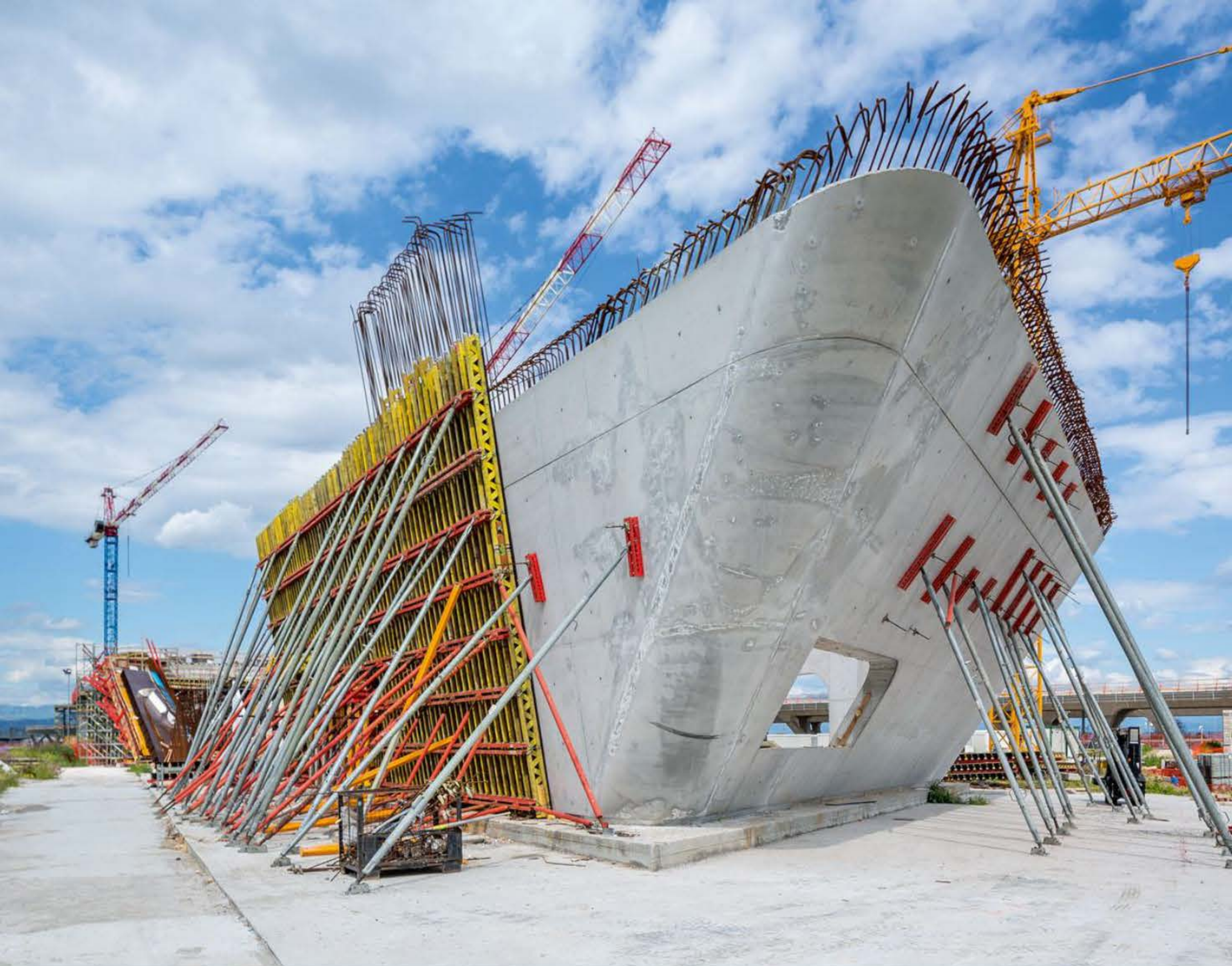
Zaha Hadid, Stazione dell'Alta Velocità e Alta Capacità (AV/AC) di Napoli Afragola, © PERI SpA
