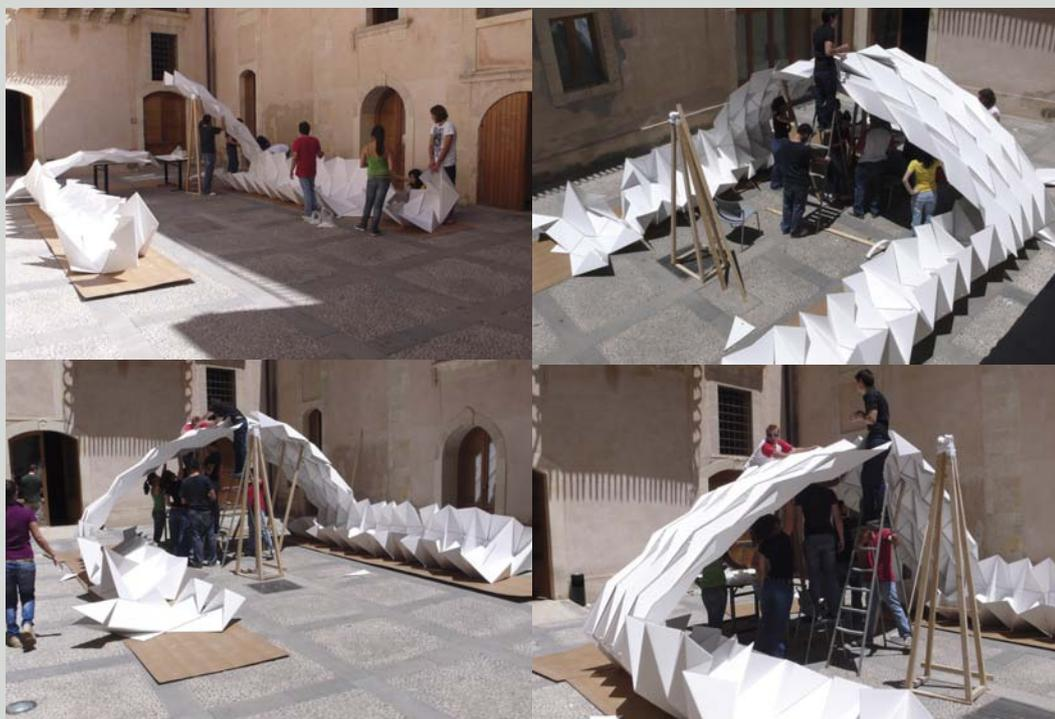
**A sinistra:** Le immagini propongono alcune delle fasi di montaggio del Cardboard Pavilion. La realizzazione può essere eseguita anche da personale non qualificato. Le dimensioni dei singoli elementi sono dettate dalle possibilità dimensionali dei macchinari per gli imballaggi e la connessione dei diversi moduli avviene con dei bottoni meccanici (vedi immagine in basso) reinseriti
